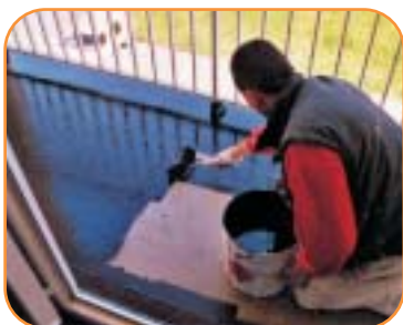
1e couche de DECOTHANE BALCONS pour le marouflage du mat de renforcement.
