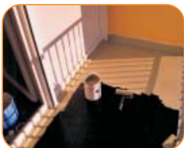
2e couche DECOTHANE BALCONS, en une autre teinte: étanche et attractive.
